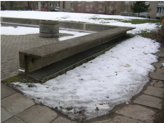
Aussenluftöffnungen im Bereich Sitzplatz in Halle 18/22.
