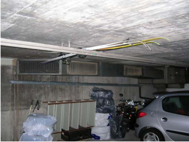
Der Zuluftventilator in Halle 24 bringt frische Luft in die Einstellhalle.
