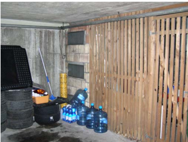
Zuluftventilator in Halle 24.
